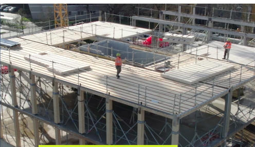
Pose du plancher HOB OA® en cours
